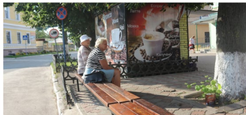
Ремонт лав для сидіння на пл. Князя Ігоря
